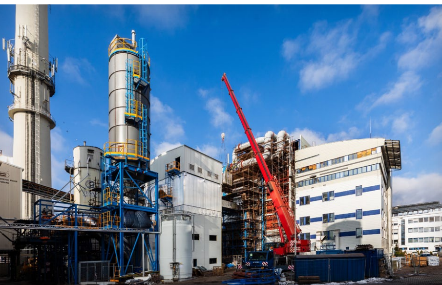
Celkový pohled na stavbu kotle K12 v areálu Teplárny České Budějovice. Zleva dokončené sílo popílku, vedle odlučovač tuhých znečišťujících látek.
