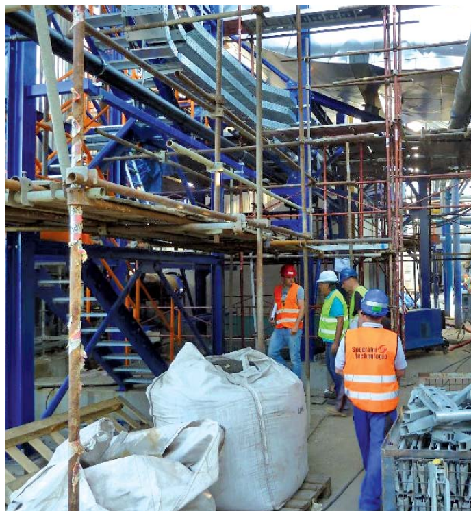
Kontrola stavu BOZP v průběhu výstavby.
